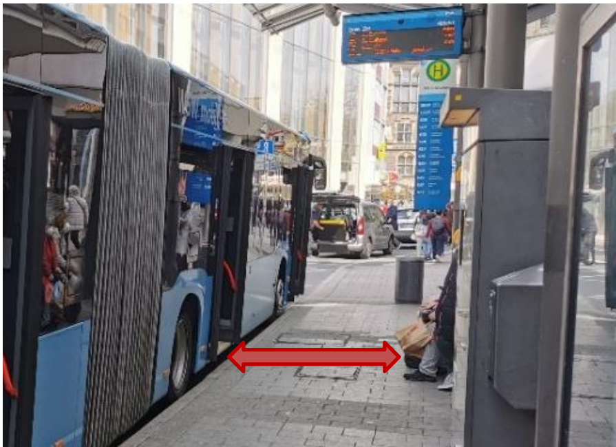
Abbildung 17: An mehreren, auch hochfrequentierten Haltestellen sind die nutzbaren Flächen für das Ausklappen der Rampe und für das notwendige Manövrieren der Rollstuhlnutzenden zu klein. (Beispiel: Haltestelle Wall/ Museum)
