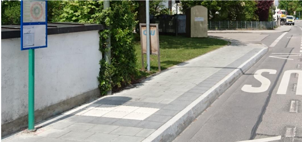
Abbildung 9: kombinierte Ausgestaltung aus Auffindestreifen und Einstiegsfeld (Beispiel: Landkreis München)
