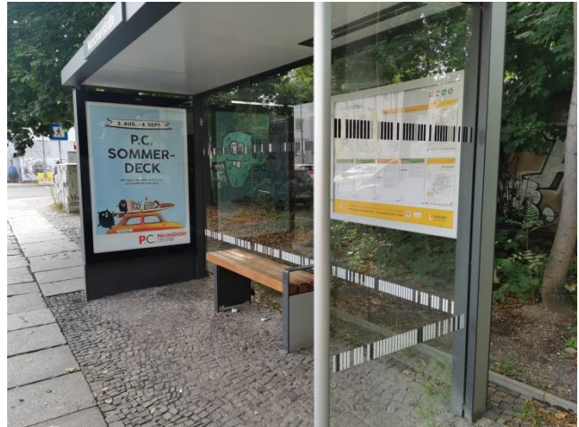
Abbildung 11: Wartehallen mit Glasflächen mit kontrastreicher Markierung nach DIN 32975 (Beispiele: links Kassel, rechts Leipzig)
