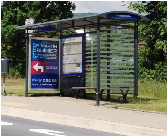
Abbildung 11: Wartehallen mit Glasflächen mit kontrastreicher Markierung nach DIN 32975 (Beispiele: links Kassel, rechts Leipzig)
