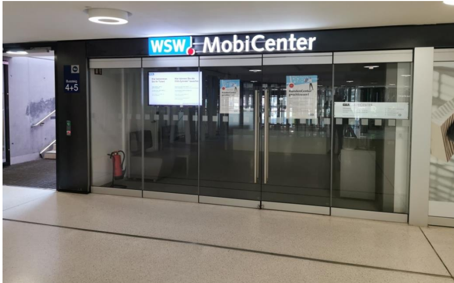
Abbildung 22: Das MobiCenter am Hauptbahnhof besitzt im Hinblick auf die barrierefreie Erreichbarkeit wesentliche Mängel (keine Anbindung an taktile Leitsysteme, Türen nicht kontrastierend, Türen nicht leicht zu öffnen u.a.)
