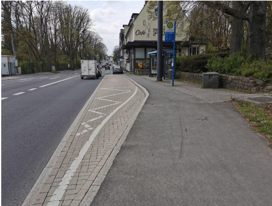
Abbildung 15: Viele Haltestellen in Wuppertal sind als Busbuch mit nicht normgerechter Ausbaulänge ausgebaut. (Beispiel: Haltestelle Cronenfeld)
