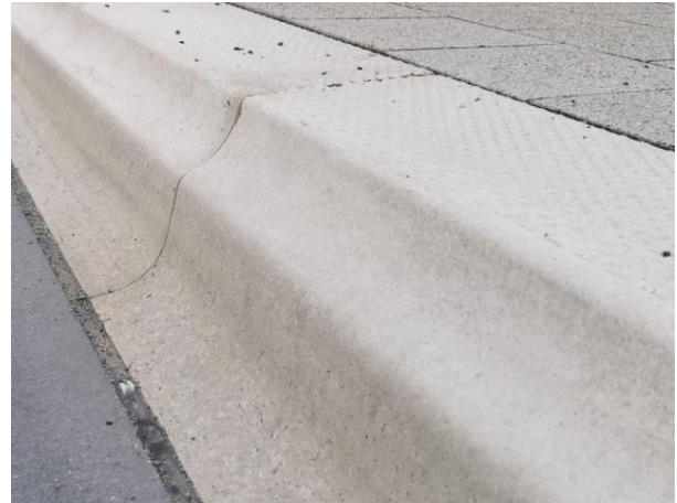
Abbildung 7: Beispiele für Sonderborde mit Spurführung (Kurven-Profil ermöglicht ein sichereres Heranfahren der Fahrzeuge an die Haltestelle); Bild rechts Sonderbord mit zweiter Hohlkehle an der Bordsteinkante zur Vermeidung von Karosseriebeschädigungen
