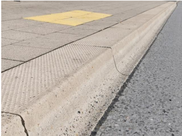
Abbildung 7: Beispiele für Sonderborde mit Spurführung (Kurven-Profil ermöglicht ein sichereres Heranfahren der Fahrzeuge an die Haltestelle); Bild rechts Sonderbord mit zweiter Hohlkehle an der Bordsteinkante zur Vermeidung von Karosseriebeschädigungen
