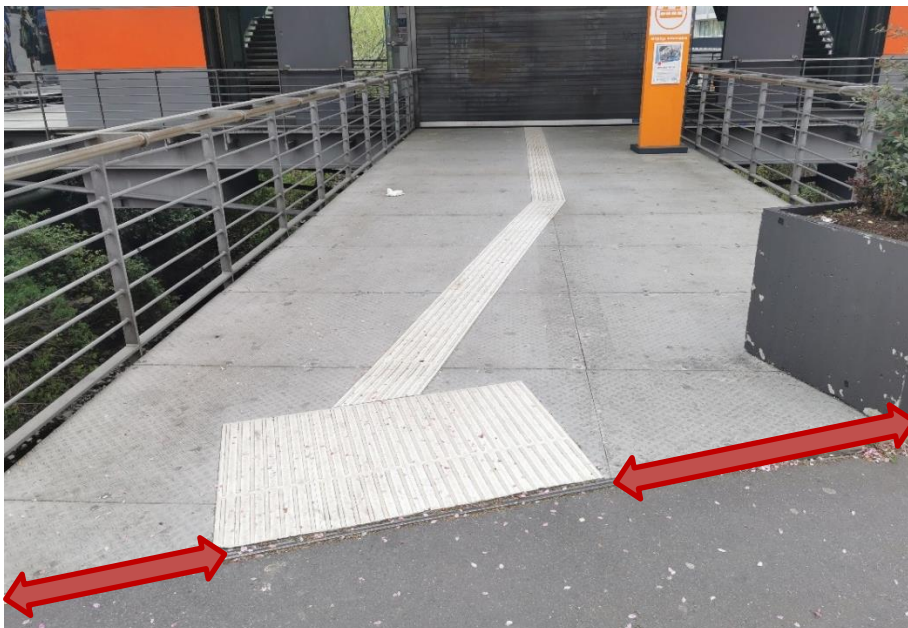
Abbildung 14: Die taktilem Leitsysteme zeigen an einigen Schwebebahn-Haltestellen Lücken in der (ertastbaren) Anbindung an das Umfeld im öffentlichen Straßenraum (Beispiel: Haltestelle Robert-Daum-Platz)
