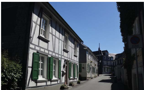
Abbildung 89: Bergisches Fachwerkhaus An der Hütte 15 1 und 3
