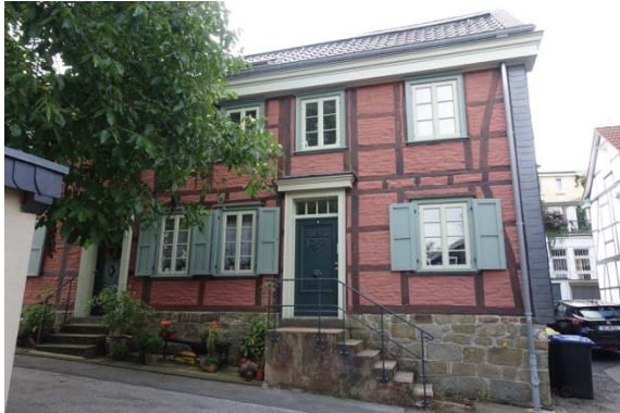
Abbildung 87: Bergisches Fachwerkhaus An der Hütte 6
