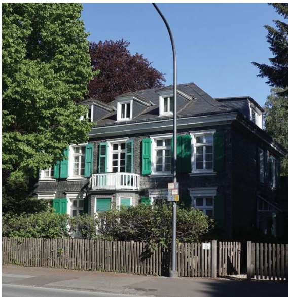
Abbildung 59: Freistehendes Wohnhaus Solinger Straße 22
