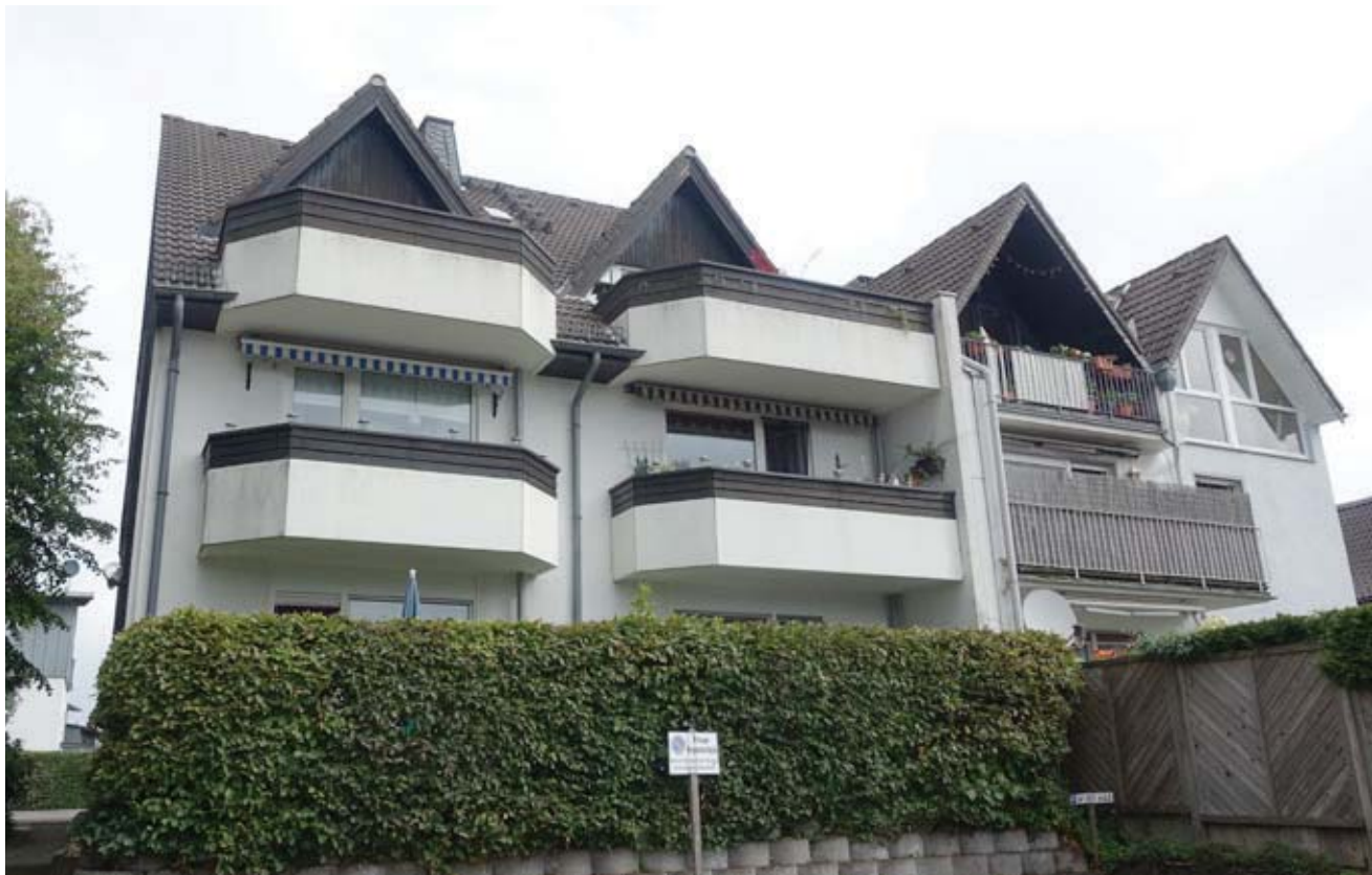
SOLINGERSTRASSE 15 & 17 (RÜCKSEITE, SCHORFERSTRASSE)
