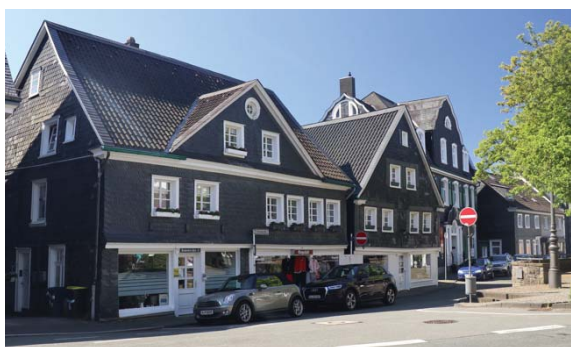
Abbildung 55: Straßenzug Schorfer Straße 1,3 und 5
