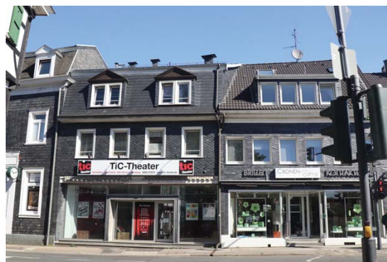
Abbildung 94: überformte Erdgeschosszone Hauptstraße 3, 5 (2020)
