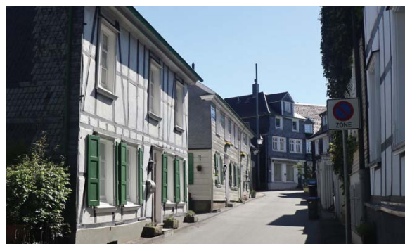
Abbildung 56: Straßenzug „An der Hütte“
