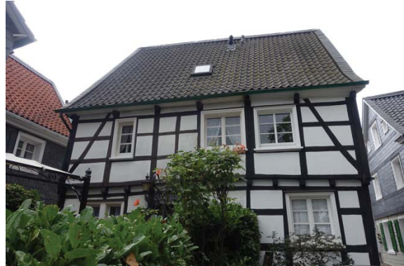
Abbildung 88: Bergisches Fachwerkhaus An der Hütte 10
