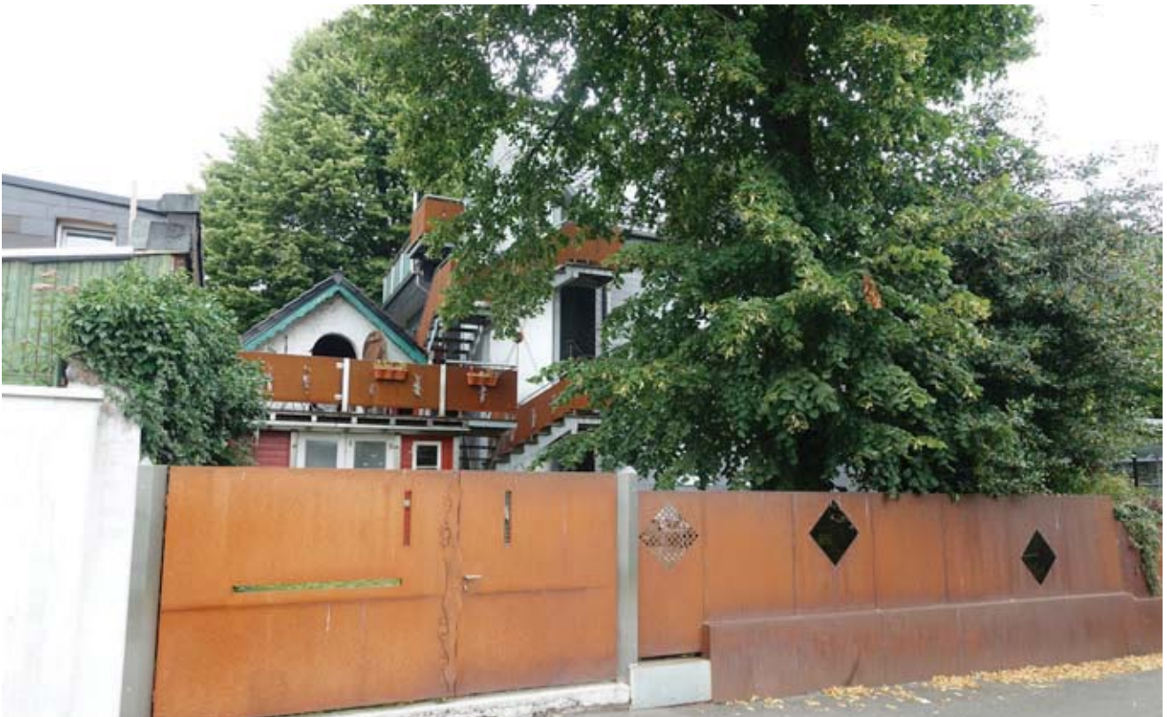
SOLINGER STRASSE 19 (RÜCKSEITE, SCHORFER STRASSE)
