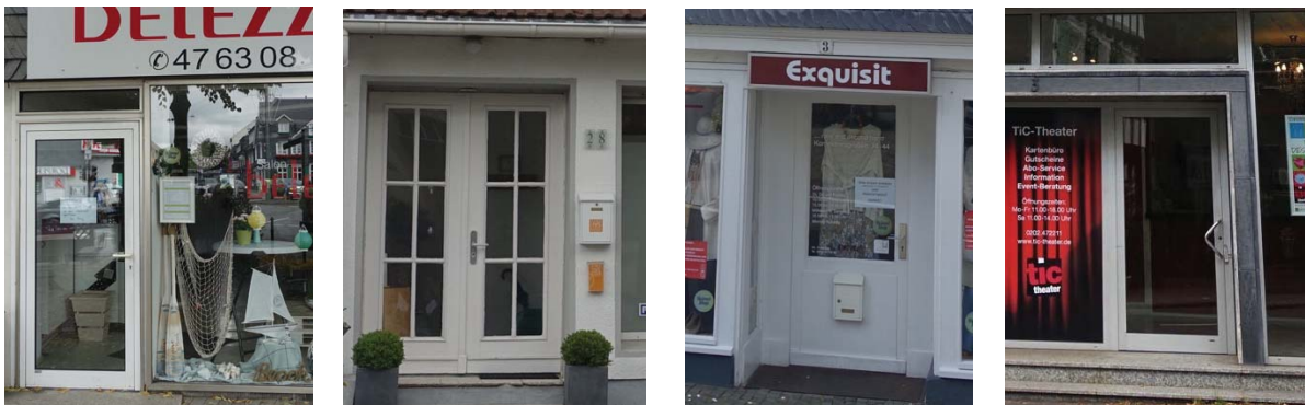
Abbildung 108: Gläserne Haustüren jüngerer Bebauung
