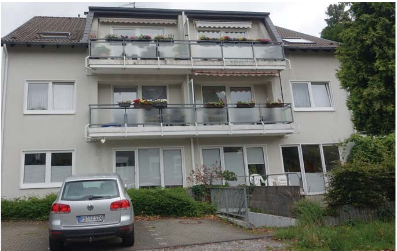
SOLINGER STRASSE 25 (RÜCKSEITE, SCHORFER STRASSE)
