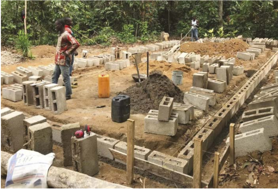
Die neue Veterinärstation im Bau -
