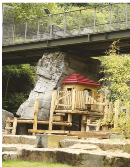
Der Wasserspielplatz wurde 2016 eröffnet
