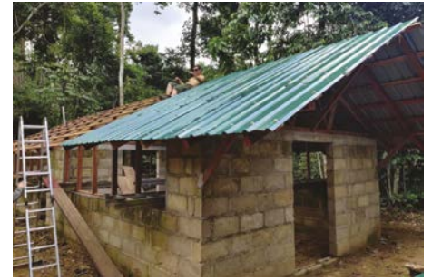
Dachmontage bei der neuen Veterinärstation
