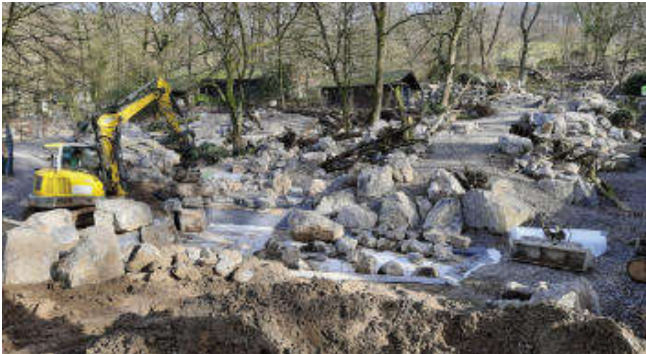
So weit sind die Bauarbeiten im März 2023 bereits fortgeschritten
