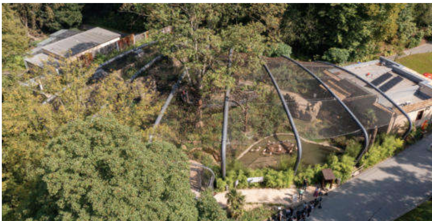
Aralandia aus der Vogelperspektive. Rechts erkennt man die Photovoltaikanlage auf dem Dach des Besucherzentrums.
