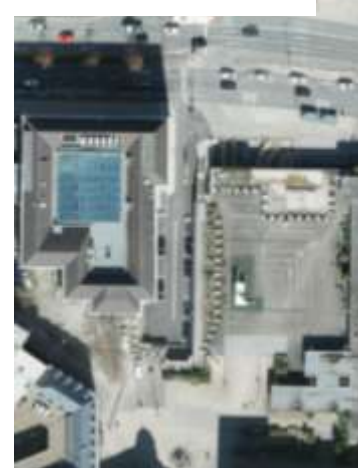
#5 OPTIMIERUNG DER GEODATEN
