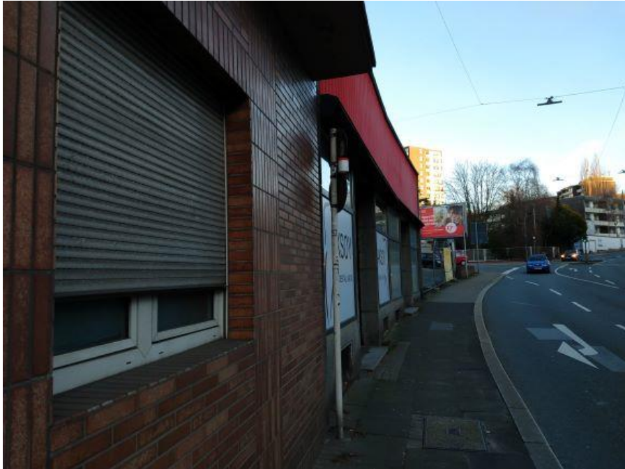
Abb. A11 Messpunkt 17 (Westkoter Straße 111)
