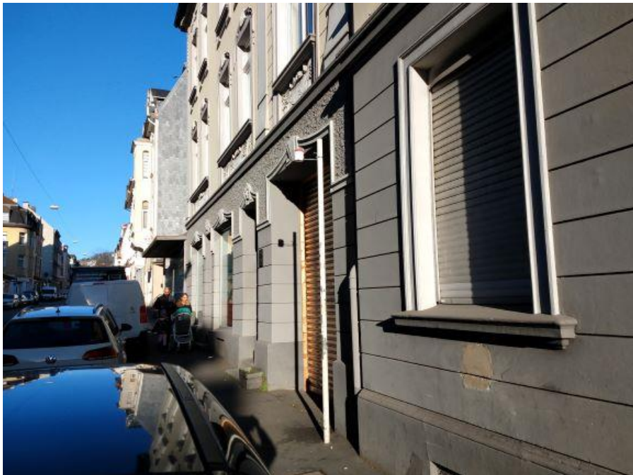
Abb. A12 Messpunkt 20 (Wichlinghauser Straße 70)
