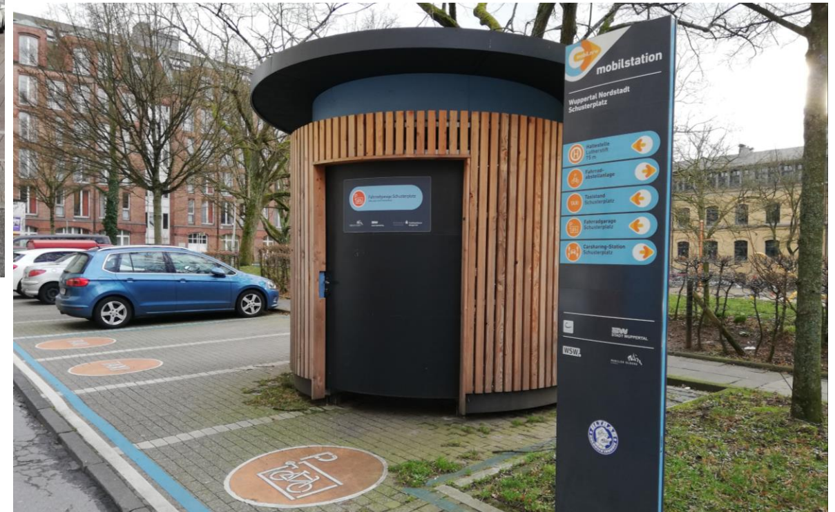
Neue Mobilstation innerhalb des Quartiers
